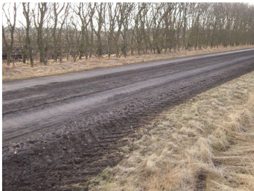
Billede 5 Kørebane tilsvinet med mudder efter gyllenedfældning. Foto: Thomas Harbo
