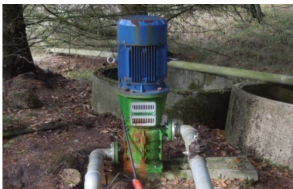
Billede 5 To år gammel trykpumpe. Bemærk de tydelige okkerstriber.
